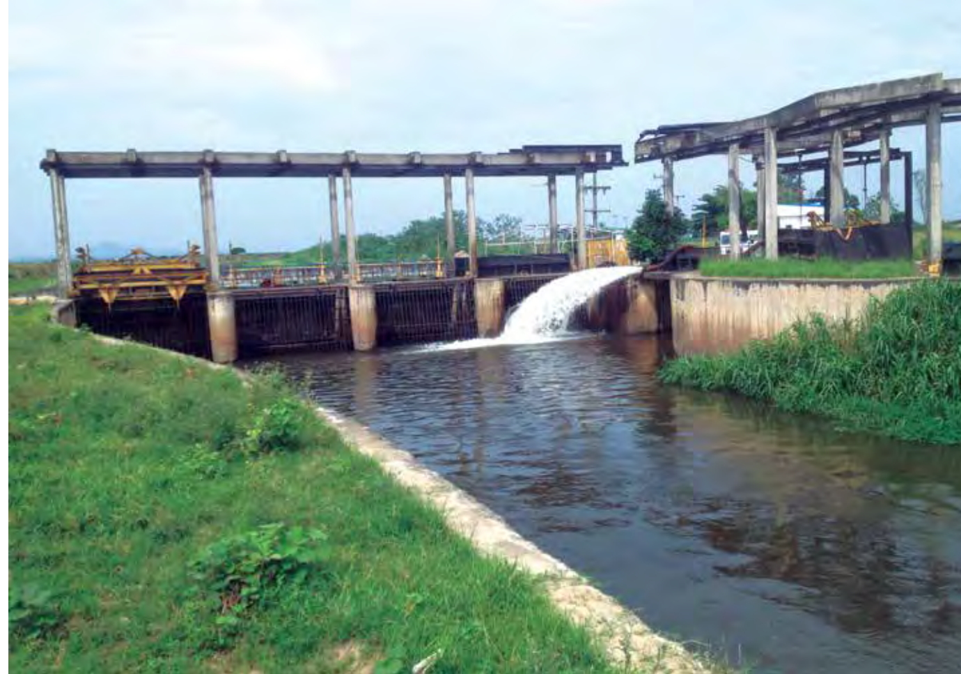
Área da captação de água para o Sistema Imunana-Laranjal (Foto: Subsecretaria de Segurança Hídrica/SEA)
