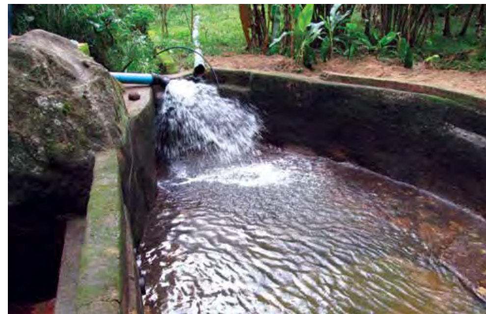
Captação de água no Rio Pedra Branca, em Paraty (Foto: Concessionária de Abastecimento Águas do Brasil)
