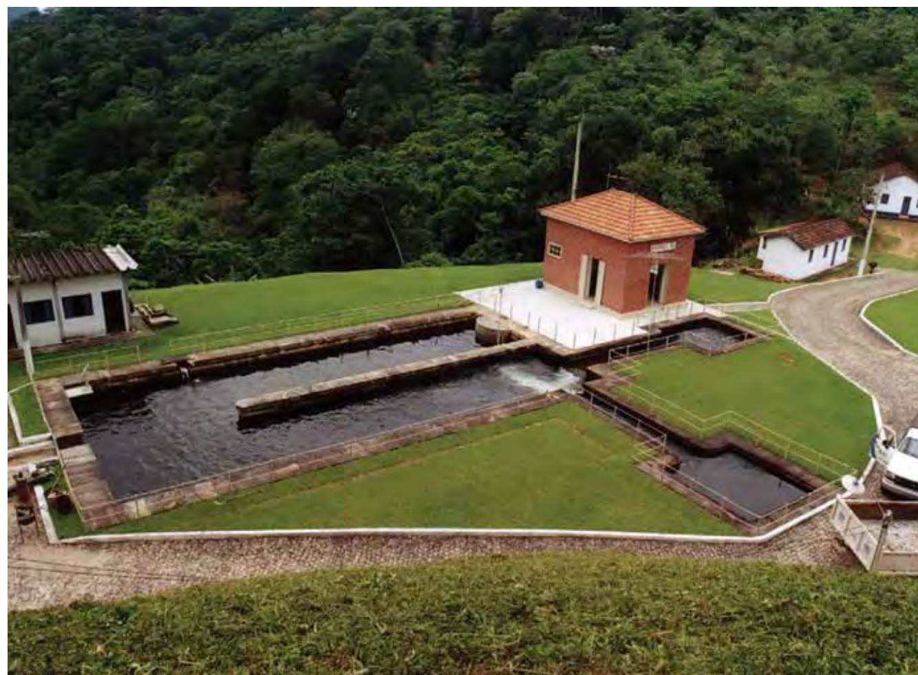
Represa de Tinguá, no Rio Tinguá, que integra o Sistema Acari de captação de água, localizado na REBIO Tinguá, em Nova Iguaçu. A área da captação e da barragem remontam ao período imperial, no século XVIII (Foto: Cosme Aquino)
