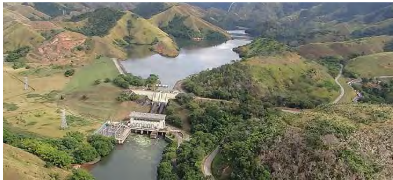
Área da barragem da UHE Pereira Passos, integrante do Sistema Light, no município de Pirai. Destaque para os morros e APP sem cobertura florestal no entorno do reservatório (Foto: Subsecretaria de Segurança/SEA)
