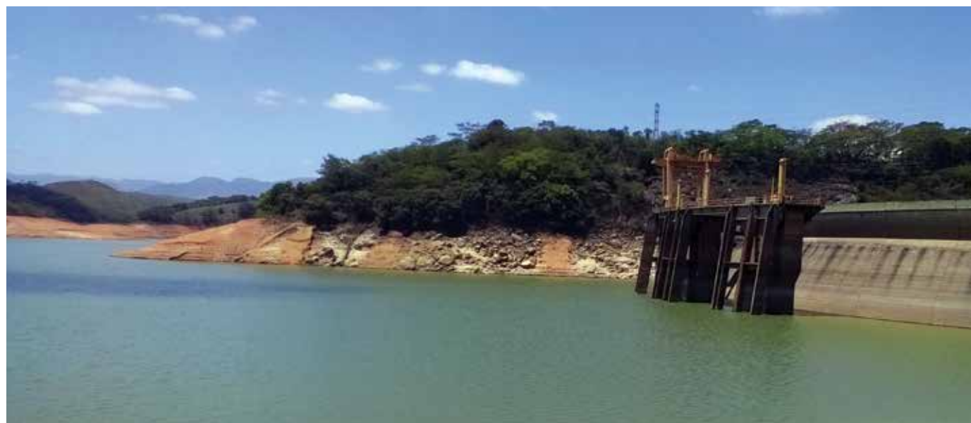
Reservatório da Usina Hidroelétrica de Funil, em Resende, pertencente ao sistema Furnas. A barragem no Rio Paraíba do Sul possibilita a regularização de vazões, reduzindo a frequência e a intensidade das cheias nas áreas a jusante. O reservatório opera em conjunto com outros três grandes reservatórios de regularização (Paraibuna, Santa Branca e Jaguari), localizados no trecho paulista da Bacia do Rio Paraíba do Sul. A foto foi tirada no período de estiagem causado pela crise hídrica (2014-2015) no Estado do Rio de Janeiro, destacando o baixo nível de água disponível no reservatório (Foto: André Leone)
