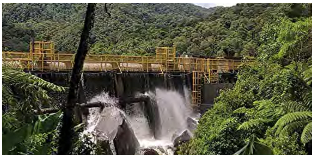
Barragem do Rio Debossan, em Nova Friburgo, com destaque para a estrutura da barragem e vegetação ombrófila densa em estágio médio-avançado (Foto: Subsecretaria de Segurança Hídrica/SEA)
