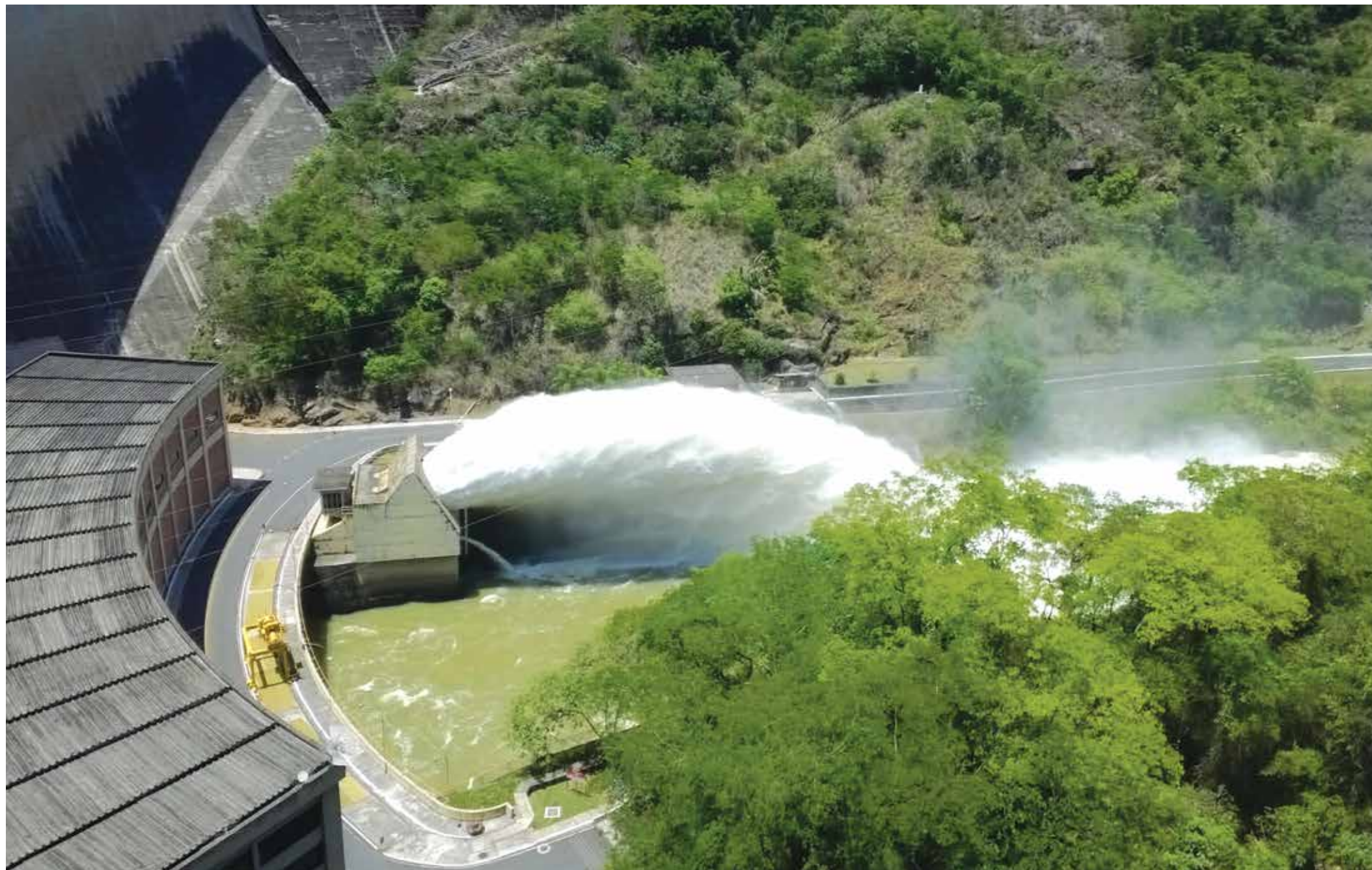
Vertedouro da Barragem do Salto do Funil, na Usina Hidrelétrica do Funil, no Rio Paraíba do Sul, em Itatiaia, integrante do Sistema Furnas de geração de energia elétrica (Foto: André Leone)
