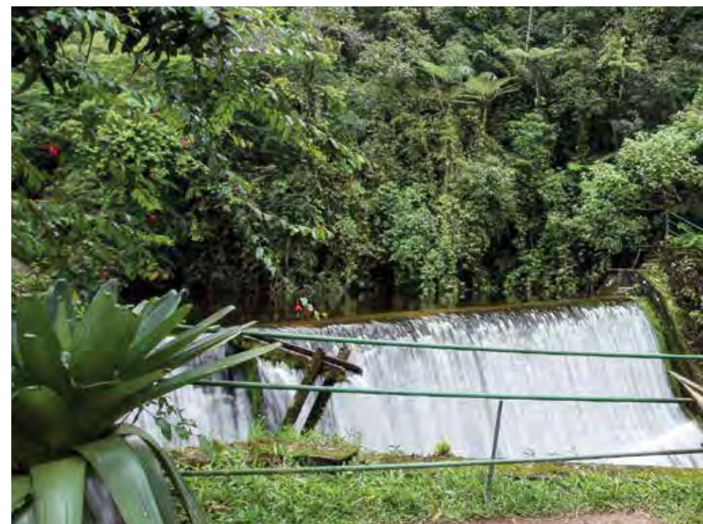
Poço da Barragem, captação de água no Parque Nacional da Serra dos Órgãos, em Teresópolis (Foto: Parque Nacional da Serra dos Órgãos)
